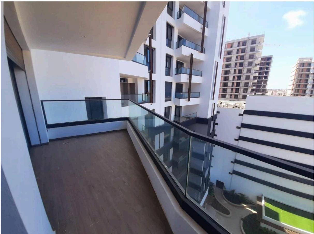
Le système de garde-corps GC ELEGANCE permet une transparence totale, Il s'agit d'un Système de fixation de verre avec des sabots de 15 cm. Le montage du verre s'effectue par des cales de serrage en plastique (sans colle et joint silicone).
