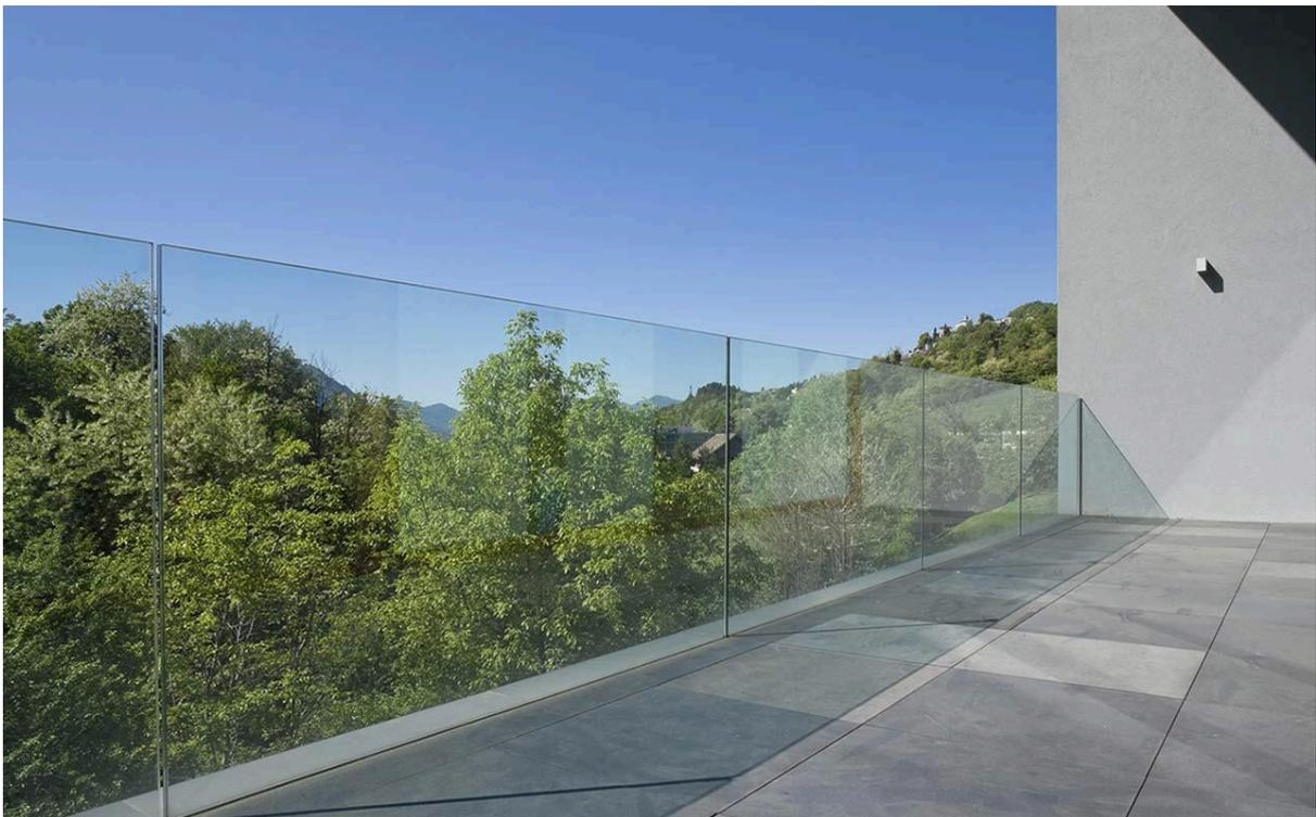
Le système de garde-corps GC ENCASTRÉ permet une transparence totale, Il s'agit d'un rail linéaire avec verre de sécurité libre, sans poteau, composé d'un profilé en aluminium. Le montage du verre s'effectue par des cales de serrage en plastique (sans colle et joint silicone).
